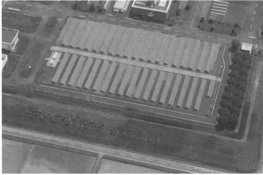
図7 吉見浄水場太陽光発電設備
