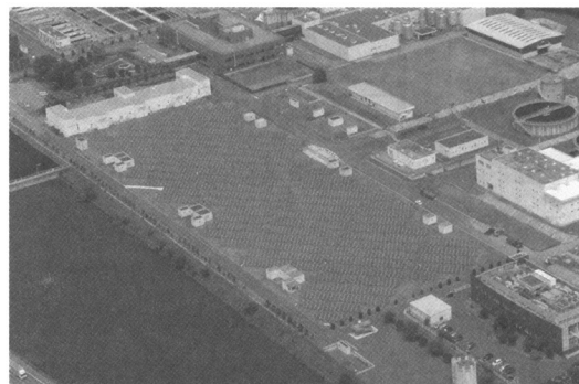
図6 行田場浄水場太陽光発電設備
