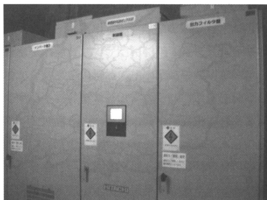
図3 回転数制御装置
