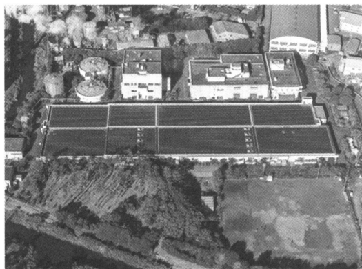
写真-5 西部浄化センター太陽光発電設備
