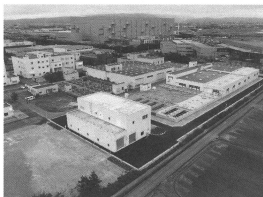
し尿・浄化槽汚泥受入施設（上空より）
