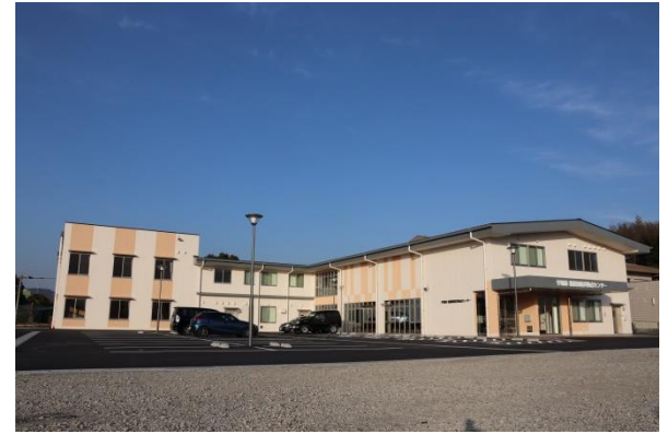
松橋防災拠点センター東
