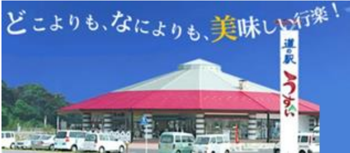
道の駅うすい外観
