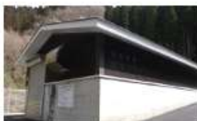
企業局若松川発電所 (日野郡日南町)
