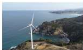
浜田生湯温泉風力発電所 (浜田市生湯町)
