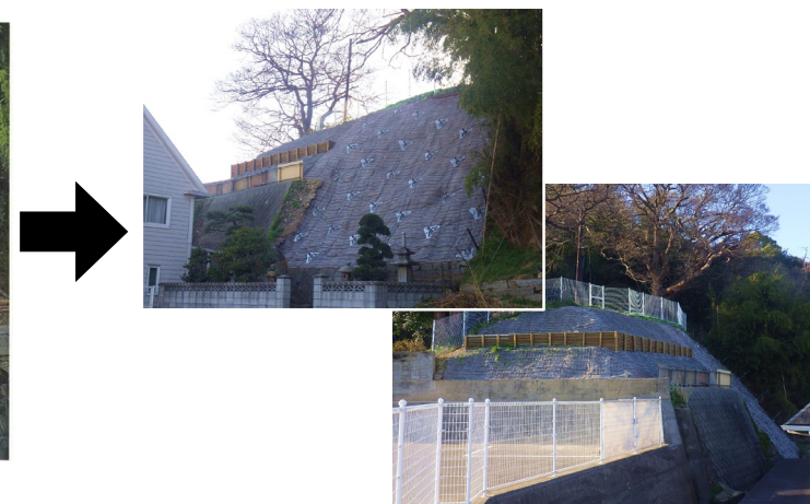
急傾斜地法面对策：施工後
