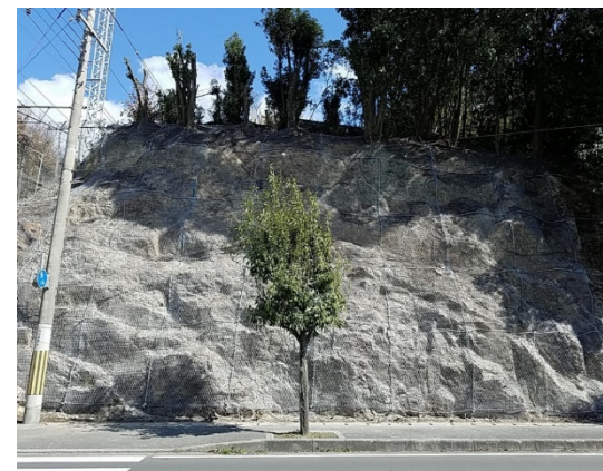
法面防護：施工後
