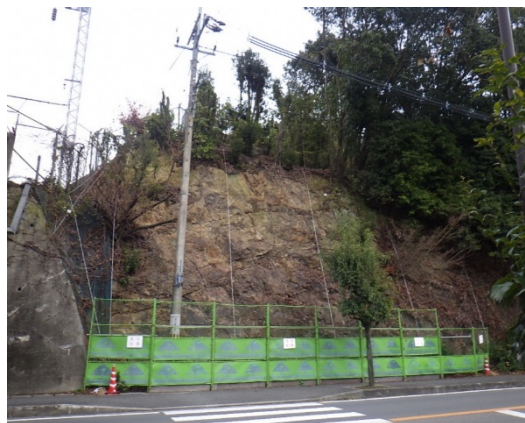
法面防護：施工前
