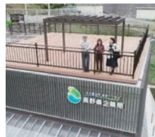
発電所/展望デッキ
