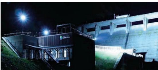
ライトアップ中の発電所
