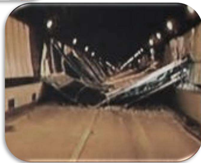
トンネル天井崩落
