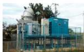
湯梨浜地熱発電所 (東伯郡湯梨浜町)
