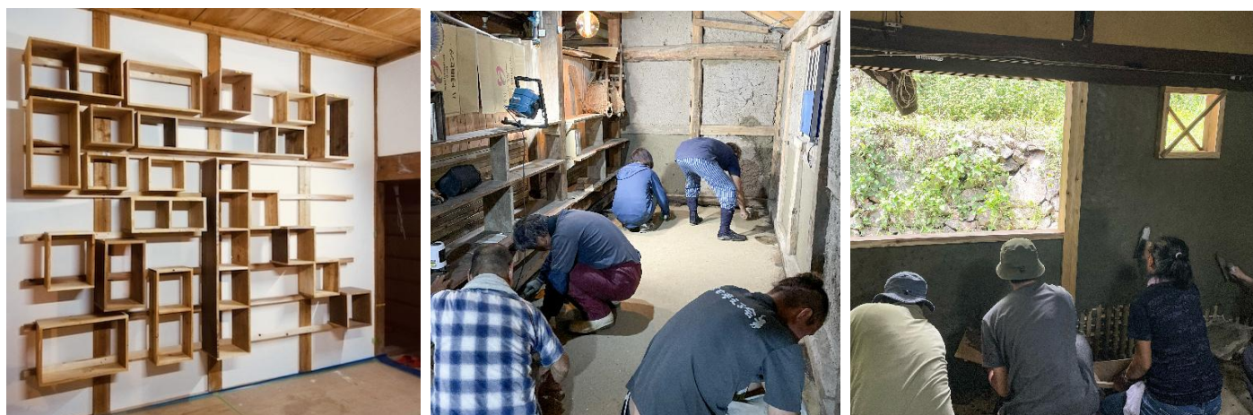
図表 5 実習の様子（左から、壁造り付け棚、三和土の作成、土壁の再生）
